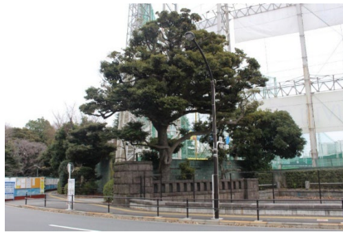
写真13 伐採されるスダジイ、マテバシイ、 撤去される震ヶ丘門
