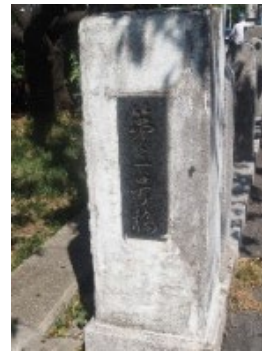
写真9 第三号橋 親柱
