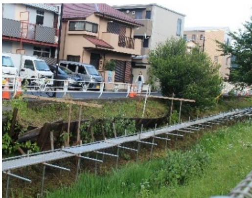
写真3 土留工事の開始（2026年6月）花壇エリア
