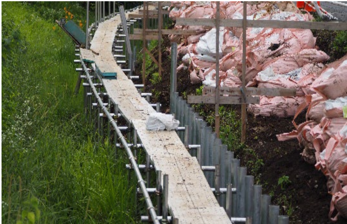
写真 42 笹塚橋の袂の土留工事 2026 年 6 月 22 日
