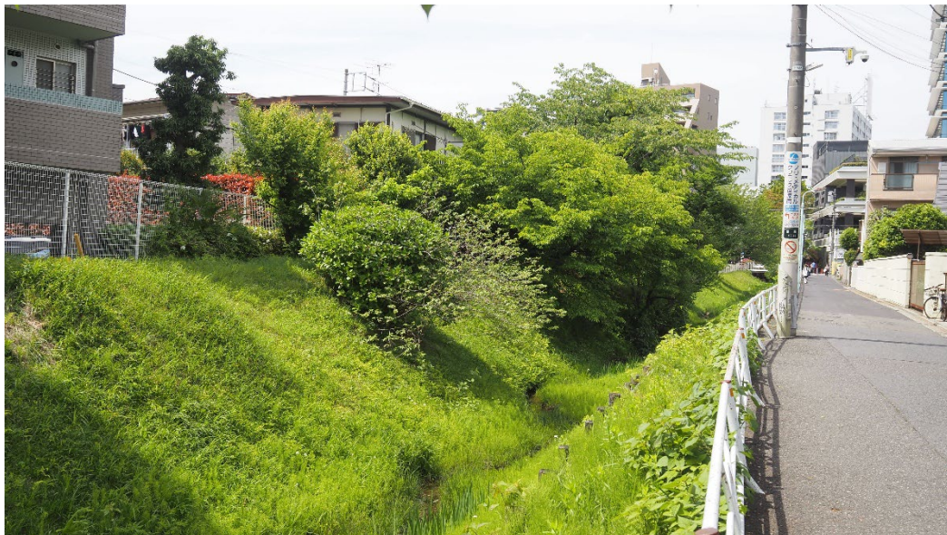
写真 29 樹林帯から下流の素掘り法面 2026 年 4 月 18 日
