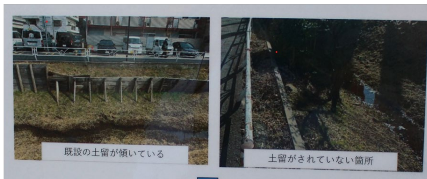
写真6 掲示板の内容 2026年6月
