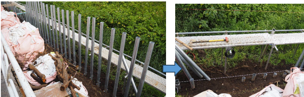
写真 56, 57 水際線に鋼管（H-1.0m）を打ち込む工法 撮影 2026 年 6 月 19 日
