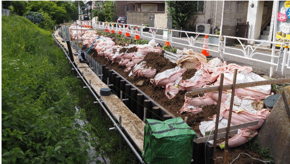
写真5 水路沿いの土留工事（笹塚橋の袂） 2026年6月17日
