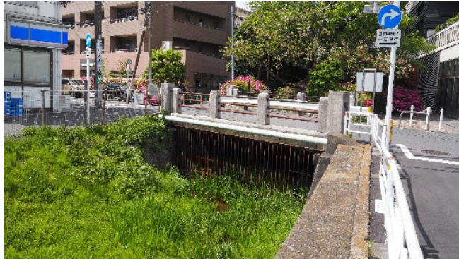
写真8 第三号橋 2026年4月7日
