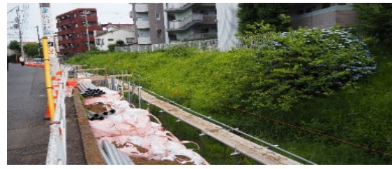
写真 34 左岸側の法面の掘削が行われたエリア（下流） 2026 年 6 月 22 日
