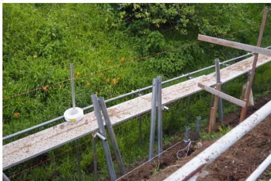
写真 69 掘削された左岸側の法面
