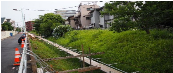
写真 33 左岸側の法面の掘削が行われなかったエリア（上流） 2026 年 6 月 22 日
