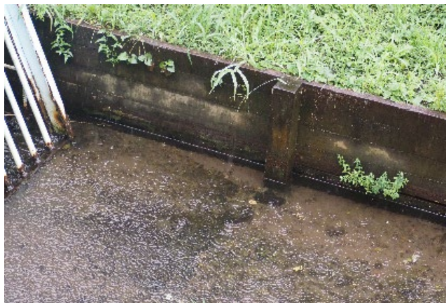
写真 119 同上 2026 年 9 月 7 日 大雨による、水位の変動は、ほとんどみられない。
