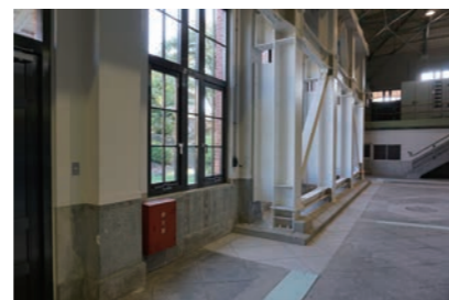
1. 旧三河島汚水処分場唧筒場施設唧筒室の全景（出典：東京都ウェブサイト） 2. 内部空間に配慮した鉄骨補強（オリジナルの尊重とバランス、不具合の解消 以前は両壁を繋ぐ過剰な補強がされていた） 3. 鉄骨補強は既存のRC構造から形状、色彩とも明確に区分されている（現代の印）
