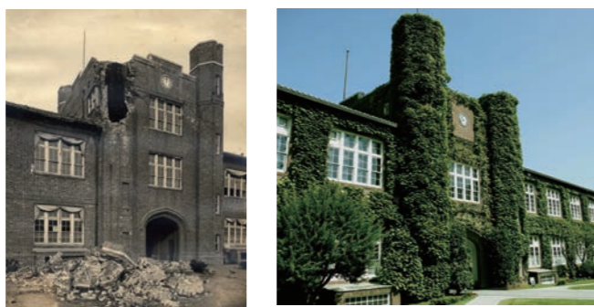
1. 本館竣工時の建物全景(提供:立教学院史資料センター) 2. 震災後の本館・広場側の状況(提供:立教学院史資料センター) 3. 現在の本館・広場側の外観
