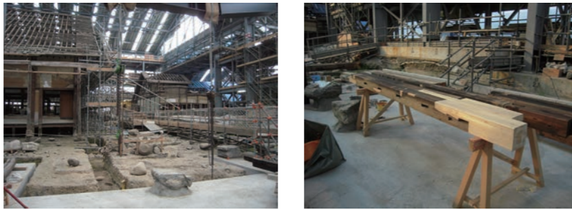
1. 修復中の工事現場の様子、建物の修復にあわせて基礎部分の発掘調査も行われる 2. 部材は一つ一つ調査し、傷んだ部分のみを修繕する
