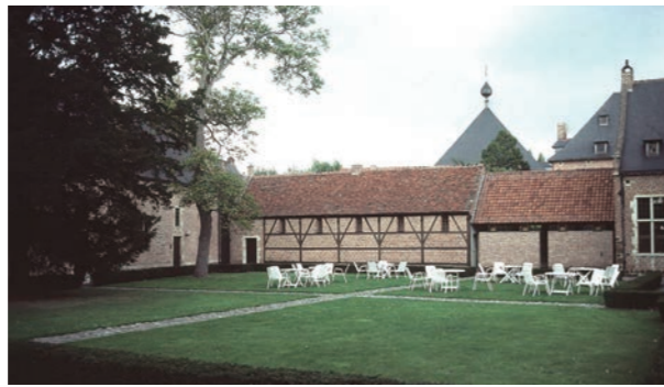
1. 歴史的地区に挿入された現代の増築部（屋根の低い部分） 2. 復原されたオリジナルのドーマー窓 3. 付加された現代のドーマー窓
