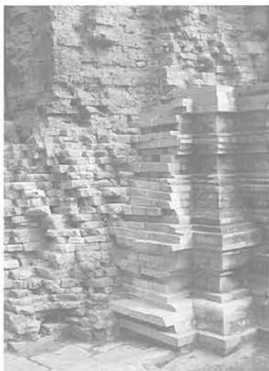
写真2 Lolei 寺院における修復箇所 (手前が新しい。かつてのレンガを覆うように新しいものを加えている。)
