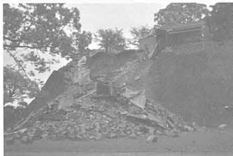
北十八間櫓の崩落
