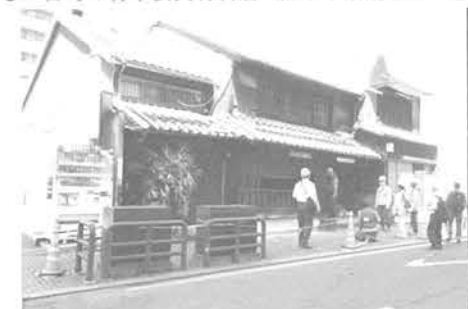
外観、瓦の落下
