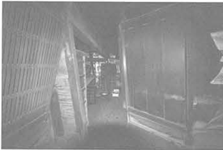
上間内部、柱が著しく傾斜し建具が外れる
