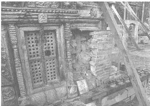
写真1 煉瓦壁内部に埋められた木柱
