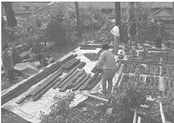
写真2 倒壊建物部材の分類整理作業
