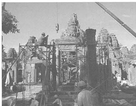
写真1 バイヨン修復現場
