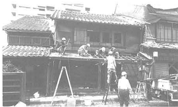
写真2 ファサード移築保存のために集まった新町・古町研究会メンバーとボランティア(大工)の活動
