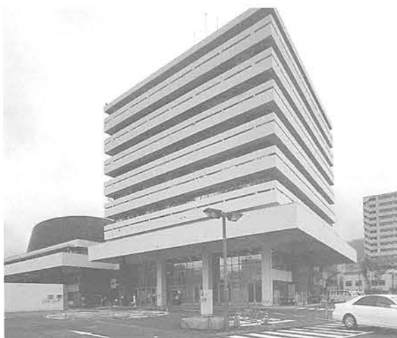
写真2 呉市庁舎：隣接した渦巻形状の市民会館は五年前前に解体され新庁舎が建てられ、現在は庁舎自体の解体が進んでいる。写真左の円形の低層部は議場。
