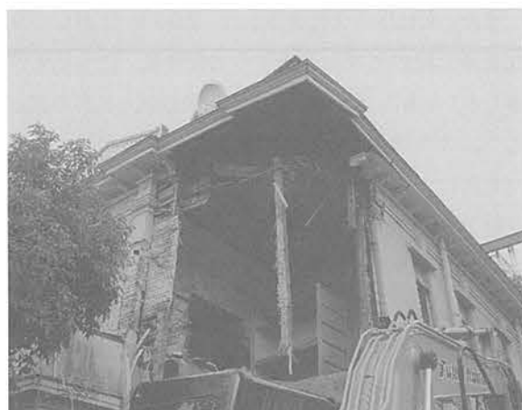
写真 2 解体中の鈴木邸（2017 年 8 月）
