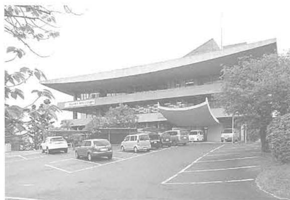
写真4 枚岡市庁舎：大庇のある四層の庁舎で塔の家で著名な東孝光が担当した。ル・コルビュジエの思考と日本の伝統がクロスオーバーした名作である。
