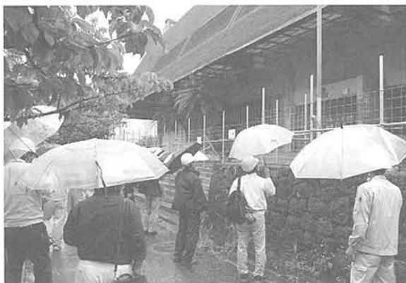
写真2 2017年6月17日 市職員案内によるコンクリートの現状視察
