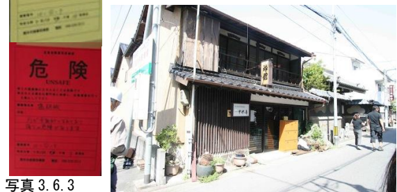
写真3.6.3 応急危険度判定 写真3.6.5 古町で被害の少ない町屋(判定:黄)
