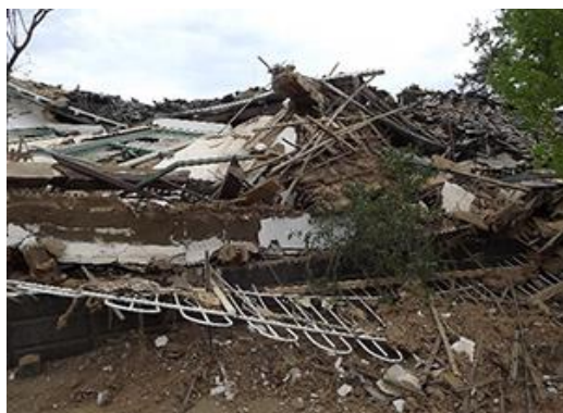
写真 3.3.15 本震で全壊した建物 その2
