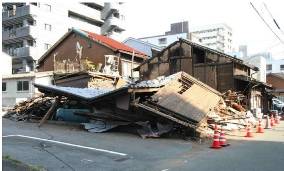
写真 3.6.24 倒壊した町屋
