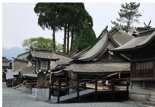
写真 3.3.3 阿蘇神社・倒壊した拝殿
