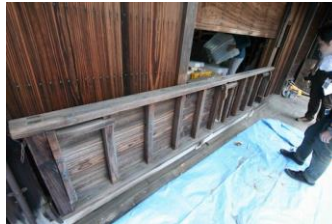
写真 3.6.14 収納した状態のバッテリー床
