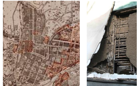
図3.6.3 太平洋戦争の戦災概況図 写真3.6.2 土蔵への蟻害
