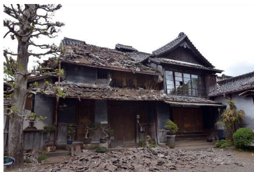
写真 3.2.1 江藤家住宅・主屋 正面
