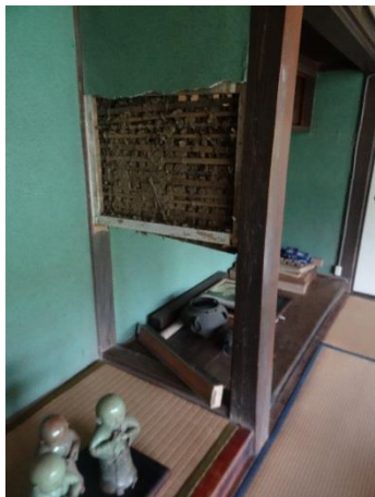
写真 3.2.12 江藤則彦家住宅 内部
