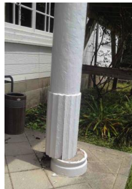
写真 3.5.4 玄関ポーチの柱のず
