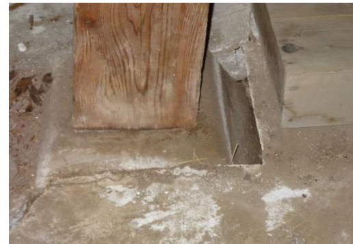
写真 3.2.27 矢野家住宅（本宅）・倉 内部
