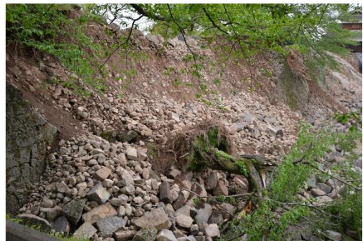
写真 3.1.7 熊本城・出丸北石垣
