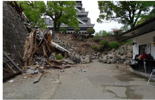
写真 3.1.6 熊本城・頬当御門 内部
