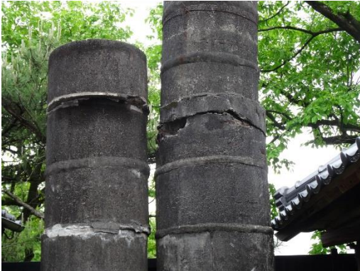
写真 3.2.11 岡本家住宅・浄化槽
