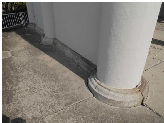
写真3.4.8 本妙寺仁王門・柱脚とその周辺
