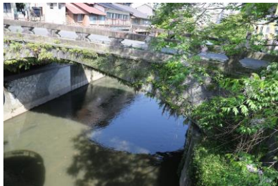
写真 3.6.23 明八橋の石造アーチ
