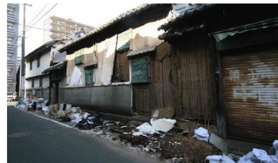
写真 3.6.11 側面に連続する複数の建物
