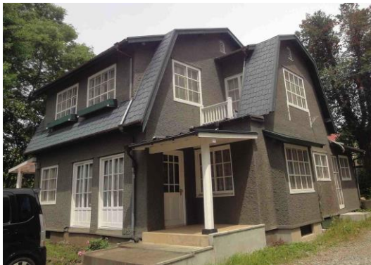
写真 3.5.1 外部窓台(プランター)が数カ所落下
