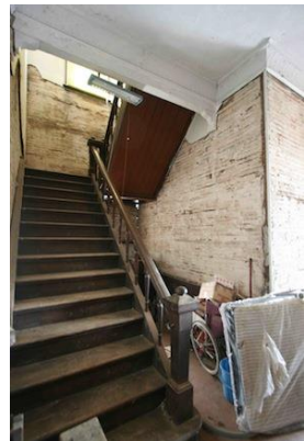
写真 3.6.18 階段周辺の壁
