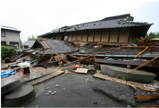
写真 G.9 1階部分が倒壊した民家
