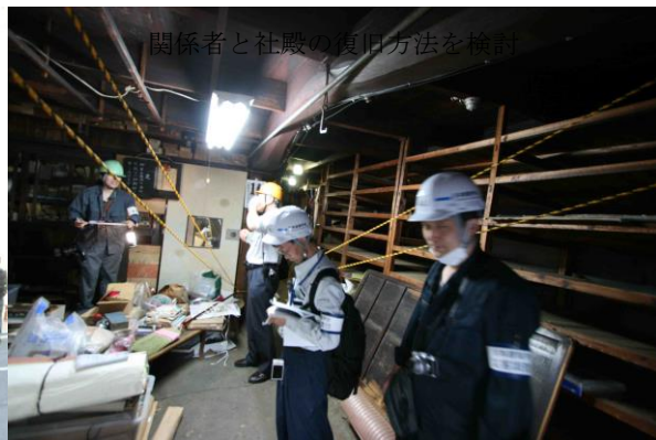
写真 G.12 内部、建物が1/20程傾斜
