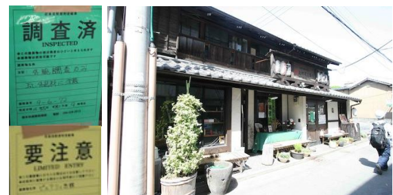
写真3.6.4 古町で被害のない町屋(判定:緑)
