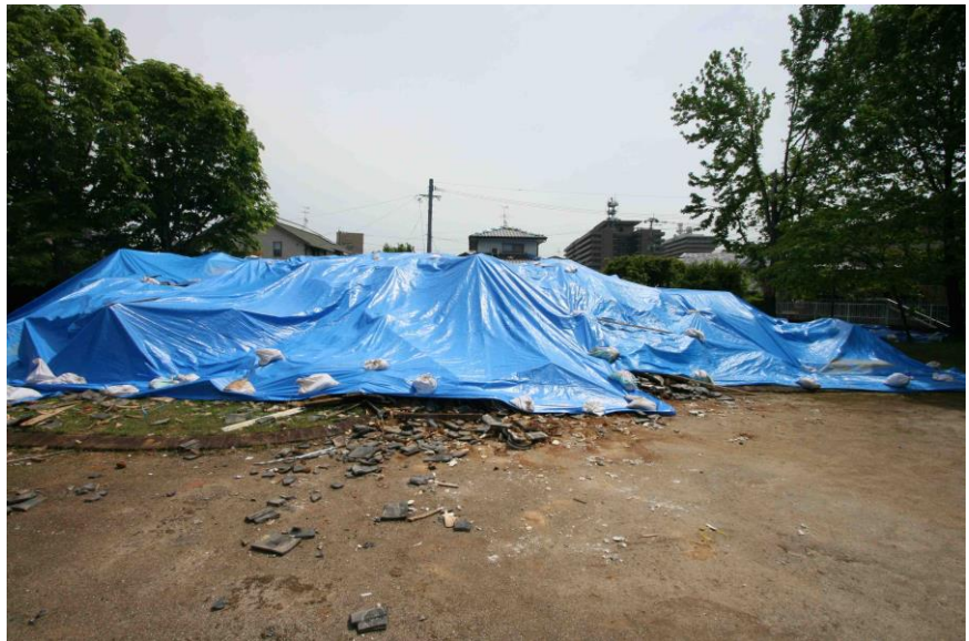
G. 17 本震で倒壊した建物を応急的にシート養生
