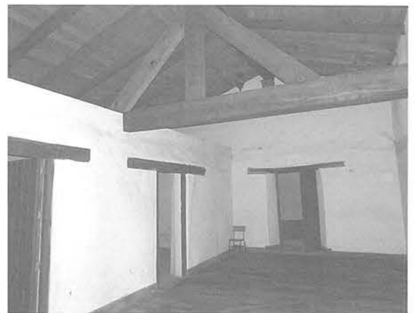
写真5 タバルバ視察：修復された病院(教会付属) 棟木を束立ての肘木で受ける。大梁の中央に立つ束に取り付いた方杖の架構は冢叉首に似る。
