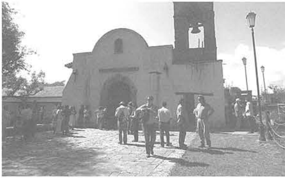
写真3 タバルバ視察：修復された教会 傾いた日干煉瓦の壁体を方杖群で総体的に立て起こし修復。小屋、天井は木造で材料は新規。
