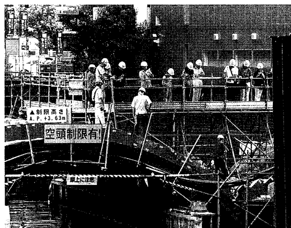
写真2 一般の見学者への解説：関東震災後の修理状況の説明
