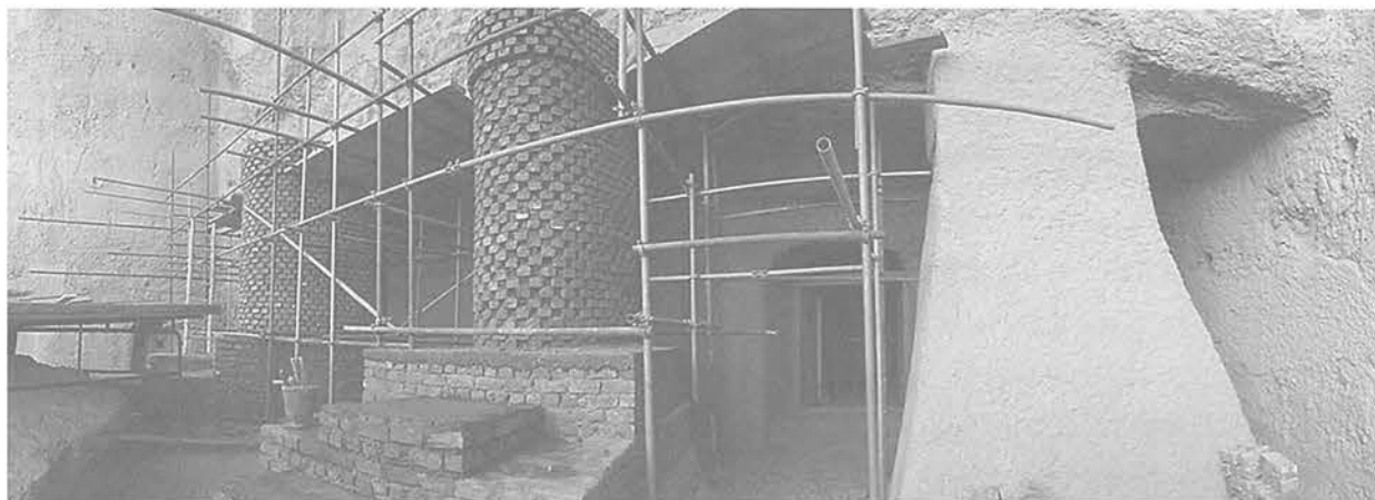
写真2 パーミヤン東大仏の「足部」建設状況②
