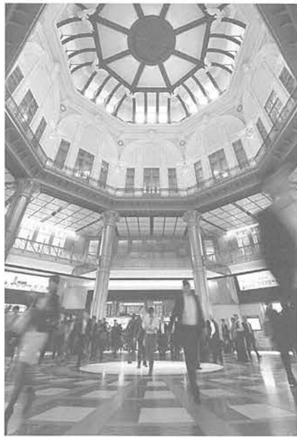
写真8 竣工後復原されたドーム 2012（平成24）年
