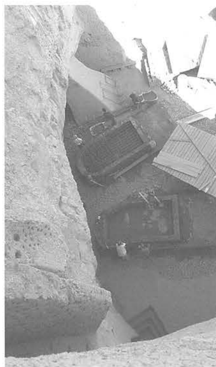
写真1 バーミヤン東大仏の「足部」建設状況①俯瞰
