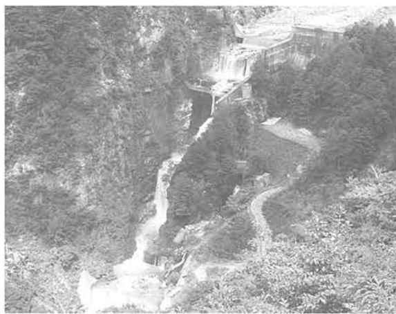
白岩堰堤砂防施設
