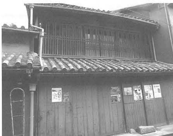
写真2 鞆に現存する最古の町家
