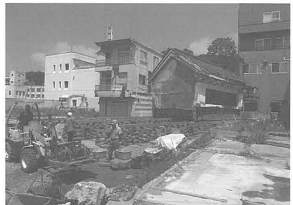
写真1 角星店舗曳き家 宮城県気仙沼市の登録文化財建造物の応急処置 (周辺市街地の復興計画が決まるまで、元の敷地に曳屋をし、養生を行う) (写真提供：気仙沼市教育委員会及び一般社団法人気仙沼風待ち復興検討会)
