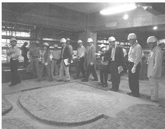
写真2 京都会館再整備工事現場：床モザイクの復元
