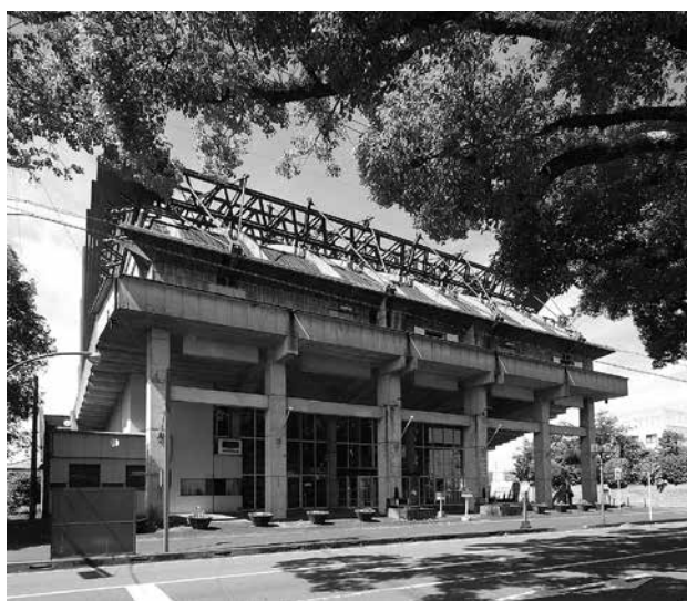
解体前の都城市民会館 躯体はしっかりしており、竣工直後に建設省の指示で設けた鉄骨の耐火被覆が落下して以来、危険な建築との風評を払拭できなかった
