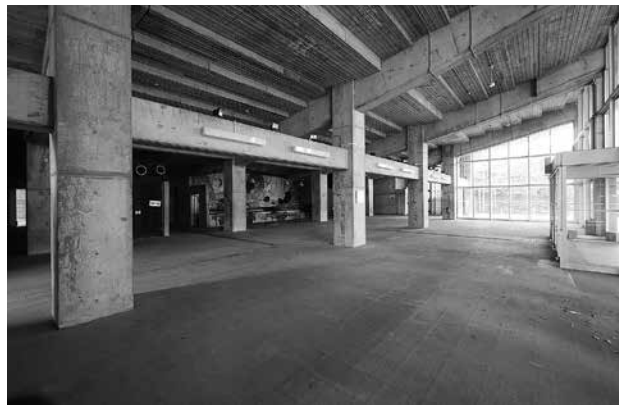
解体前の1階エントランス
