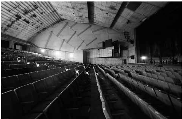
解体前のホール内部
