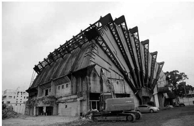
解体中の都城市民会館（外観）
