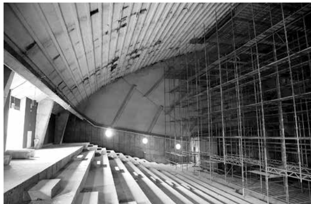
足場のかかった都城市民会館（内観）
