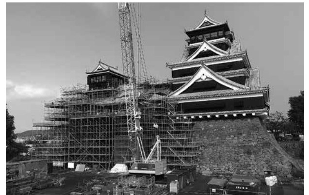
天守閣工事状況 (2020年9月)
