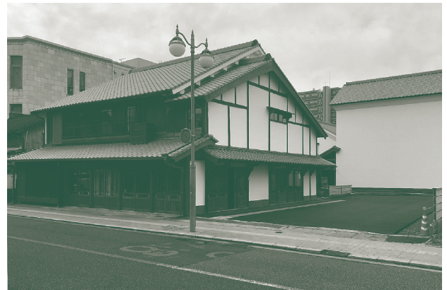
清永本店復旧工事竣工（熊本県熊本市、2020年3月、富士川一裕撮影）
