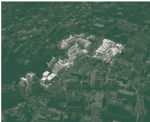
ヒルサイドテラス（写真：ASPI）
