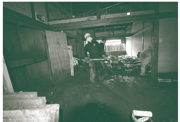
2020年7月九州豪雨にて被災した人吉旅館 （熊本県人吉市、2020年7月12日、磯田節子撮影）
