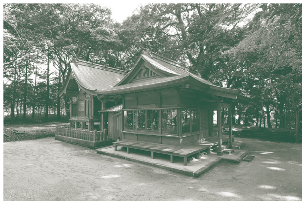
写真3 宮山神社 竣工（武田学撮影）
