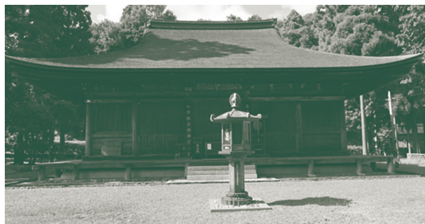
重要文化財・中山寺本堂(福井県高浜町中山)
