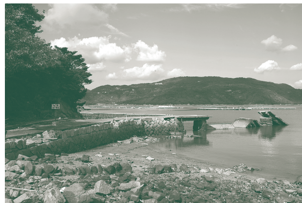
長島愛生園患者収容桟橋 (1939 年築)
