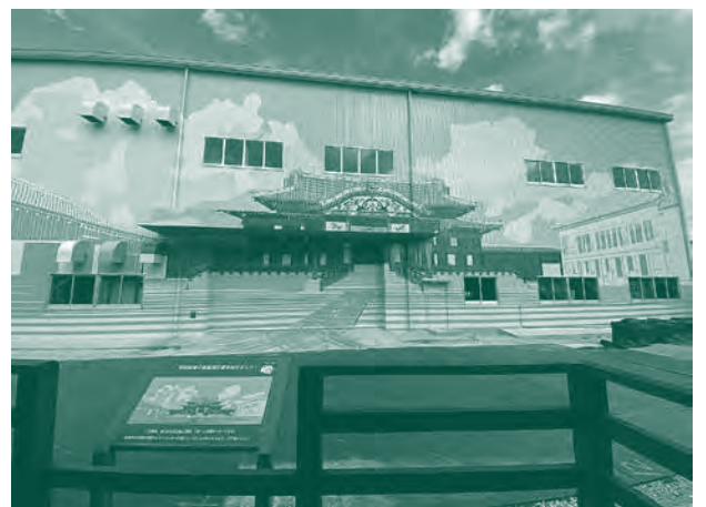
復元工事中の首里城正殿
