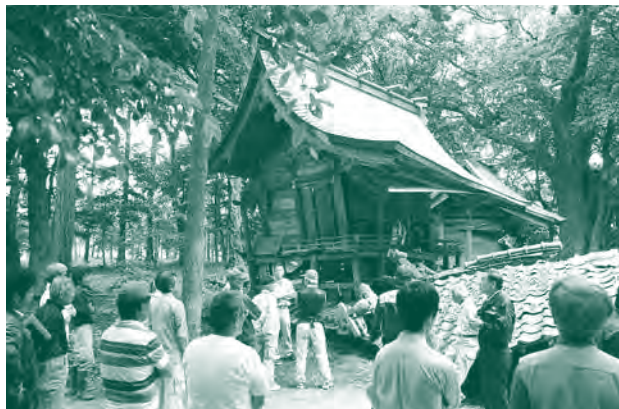
熊本県西原村・宮山神社竣工時（上）と被災後（下）の様子
