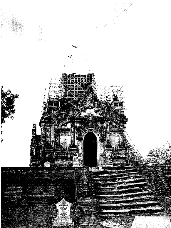
写真4 バガンの修復中のパゴダの例 (IZA GAWHA PAGODA)
