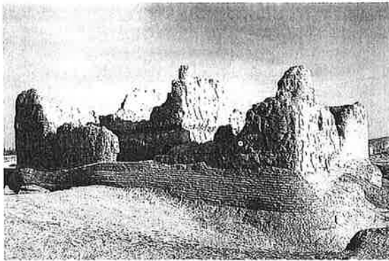
西北小寺院背面 修理前
