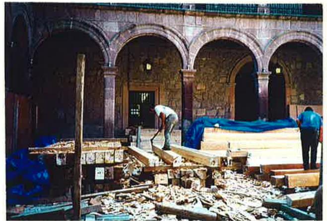
4 モレリアの州庁舎の回廊の修復工事の現場。大引の 仕上げに、日本と同じ姿勢で斧を使っています。
