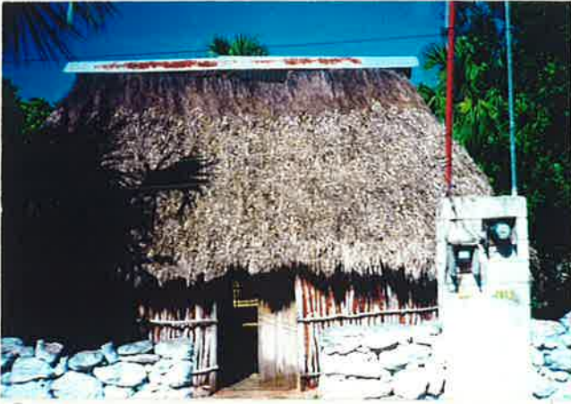
5 バスのなかから見た茅葺きの農家。正面は入口の他に開口部がなく、おそらく1室住居でしょう。
