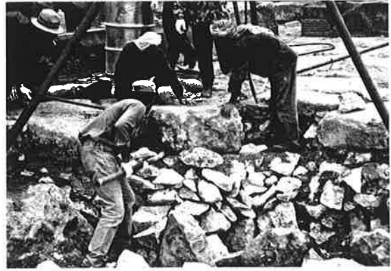
写真6 奥室床面の嵩上げ作業
