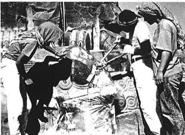
写真4 レリーフ石への樹脂注入、充填処置
