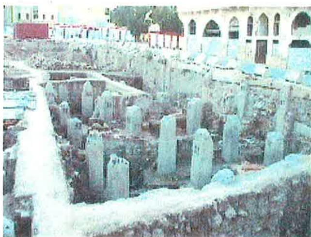
ベイルート市内の遺跡発掘（ビルの基礎杭が見える）
