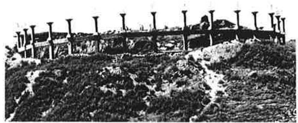
写真3 遺跡の周りに建てられた鉄筋コンクリート柱
