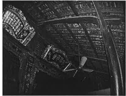
写真-7 同上 内部の状況
