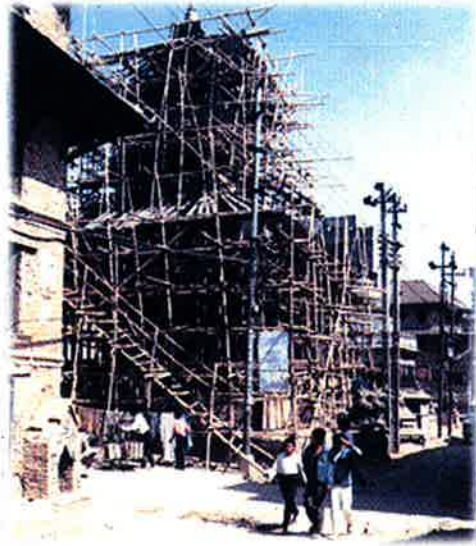
写真2. ラダ・クリシュナ寺修復中
