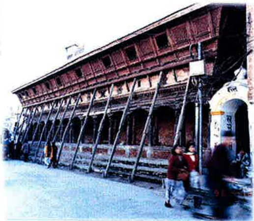
写真3. パタン王宮前広場休屋修復後
