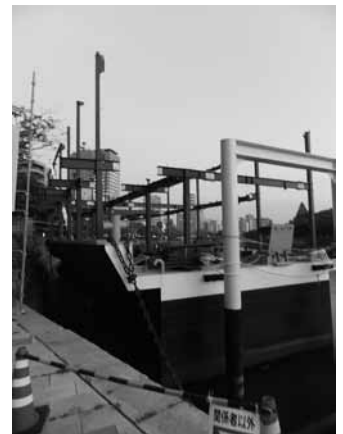
写真2 工事が進められている牡蠣船
