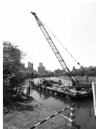
写真1 工事が進められている牡蠣船
