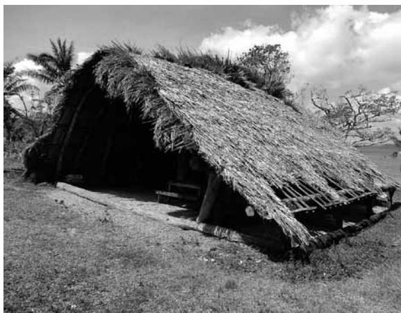
写真1 バヌアツの伝統的木造集会所（掘立て垂木構造・草葺き、強風に強く村人の避難所）
