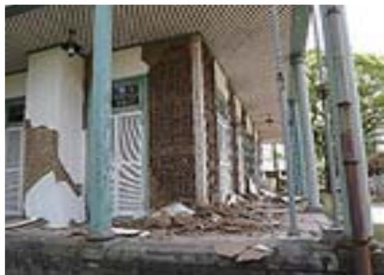
写真 2.5.4 前震による被害状況(正面左)
