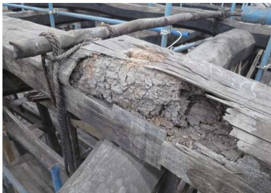
写真 2.2.11 土間上の破損 梁の蟻害が顕著
