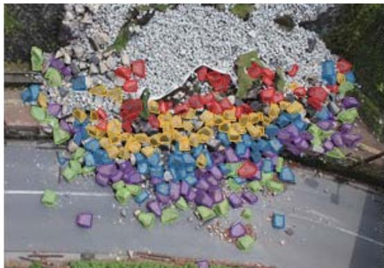
図 2.1.3 宮内の石垣の崩落状況
