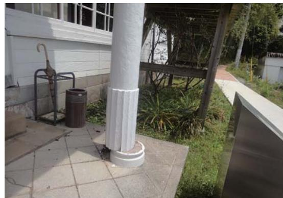
写真 2.17.4 玄関ポーチの柱のずれ
