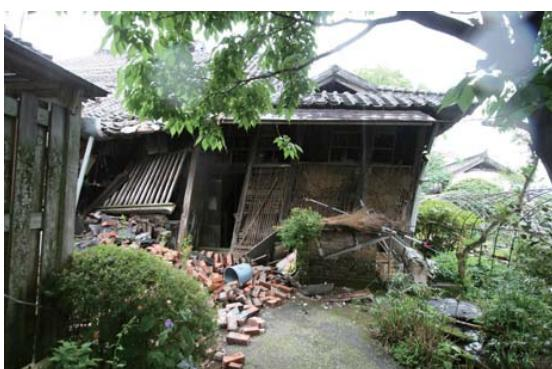
⑤江藤家住宅 柱や壁が著しく傾斜し壁も崩落した裏手
