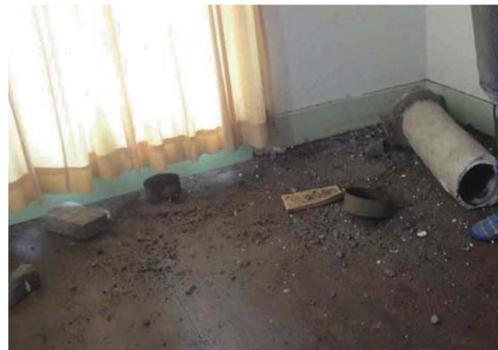
写真 2.17.2 煙突が脱落し室内に落ち込んでいた
