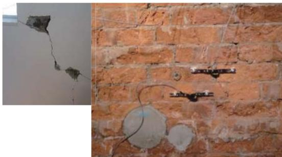
写真 2.12.5 煉瓦壁面の亀裂変位モニタリング
