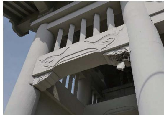
写真 2.14.2 本妙寺仁王門・柱頭・中間梁・肘木の破損（筆者撮影）
