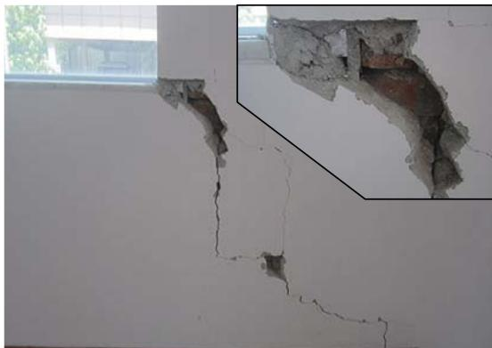
写真 2.12.3 開口部に生じたひび割れ
