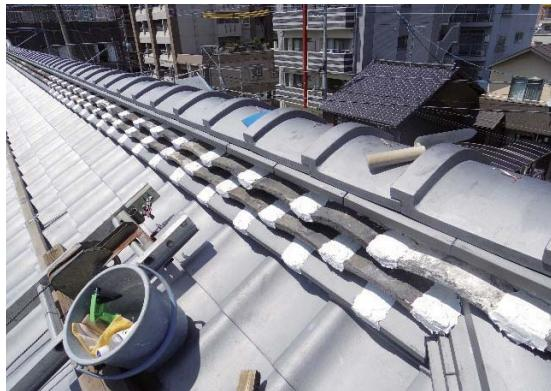
写真 2.6.6 当初の瓦を用いた大棟の復原（主屋）
