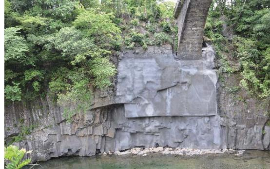
写真 2.18.6.3 復旧後の崩落部（写真右上が橋台）
