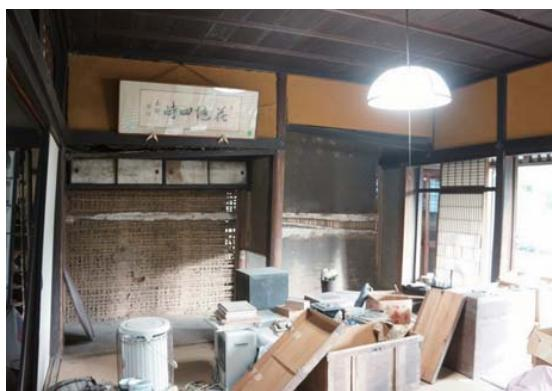
写真 2.9.5 座敷 内部 土壁が落下
