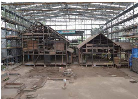
写真 2.2.13 土間棟解体完了
