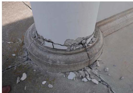
写真 2.14.4 本妙寺仁王門・柱脚の破損（筆者撮影）
