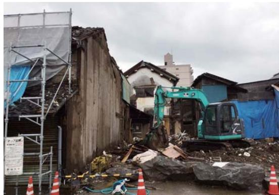
写真 2.10.2 隣接する町屋の取壊し 2016.7.3
