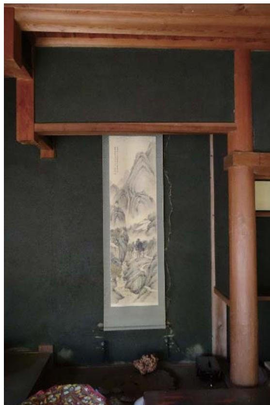
写真 2.3.2.3 矢野家住宅（新宅）・トコ壁の亀裂
