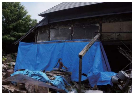
写真 2.9.4 土間北側の倒壊した下屋部分
