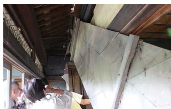
写真 3.3.2 塩屋の縁側の天井が落ちる
