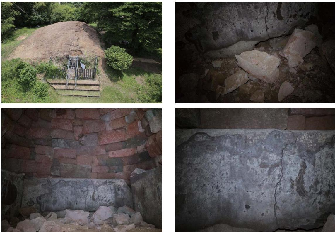
写真 2.19.1 井寺古墳 墳丘の亀裂と石室の被災状況（嘉島町教育委員会提供）
