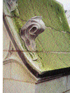
Green algae growing on a limestone buttress. 石灰岩のバットレスに生じる緑藻類。
