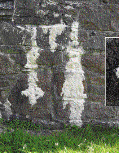
Calcite encrustation linked to water leached from joints, on a granite, sandstone and schist ashlar. 花崗岩、砂岩、切石片岩の目地から浸出した水分と関連する 方解石のエンクラステーション 。
