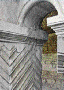
Calcite encrustation covering a limestone masonry under an arch. 方解石のエンクラステーション アーチ下部の石灰岩の石積みを覆う。
