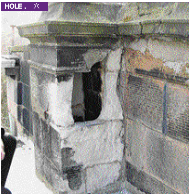
Chimney structure showing hole and loss of sandstone masonry. 煙突の構造中に穴が認められる。砂岩製の石造建築の一部が消失している。
