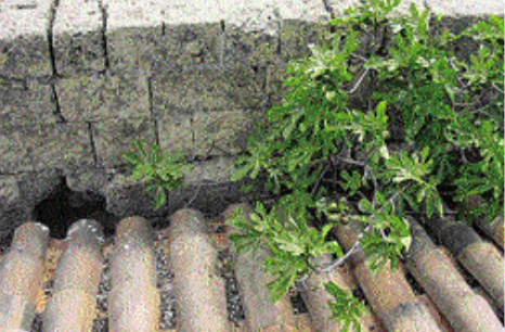
Higher plant (Fig tree) growing on a roof. 屋根上に生育する高等植物 (イチジクの木)。
