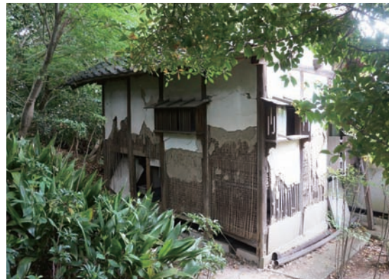
Photo 3.1.10.6 The toilet: Collapsed earth wall.
